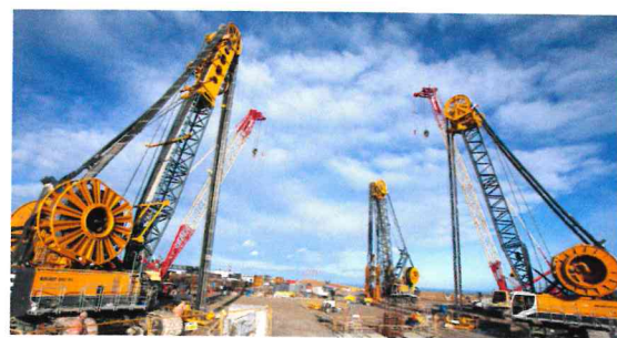
Bild 5: Schlitzwandherstellung – Maschinen im Einsatz Quelle: Sirium Minerals PLC
