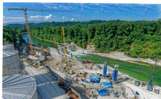
Bild 3: Bauphase 2: DSV-Arbeiten am Einlaufbauwerk Foto: ARGE KW Danzermühl
